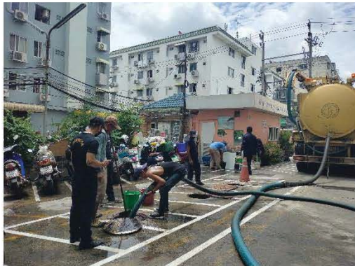
การสูบล้างจากระบบบำบัดน้ำเสีย
